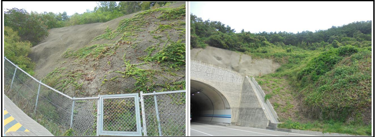
【사진 2.3.21】 사면 전경
