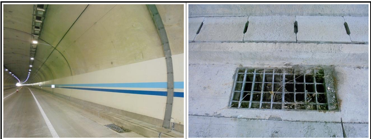
【사진 2.3.23】 공동구 및 배수시설 전경
