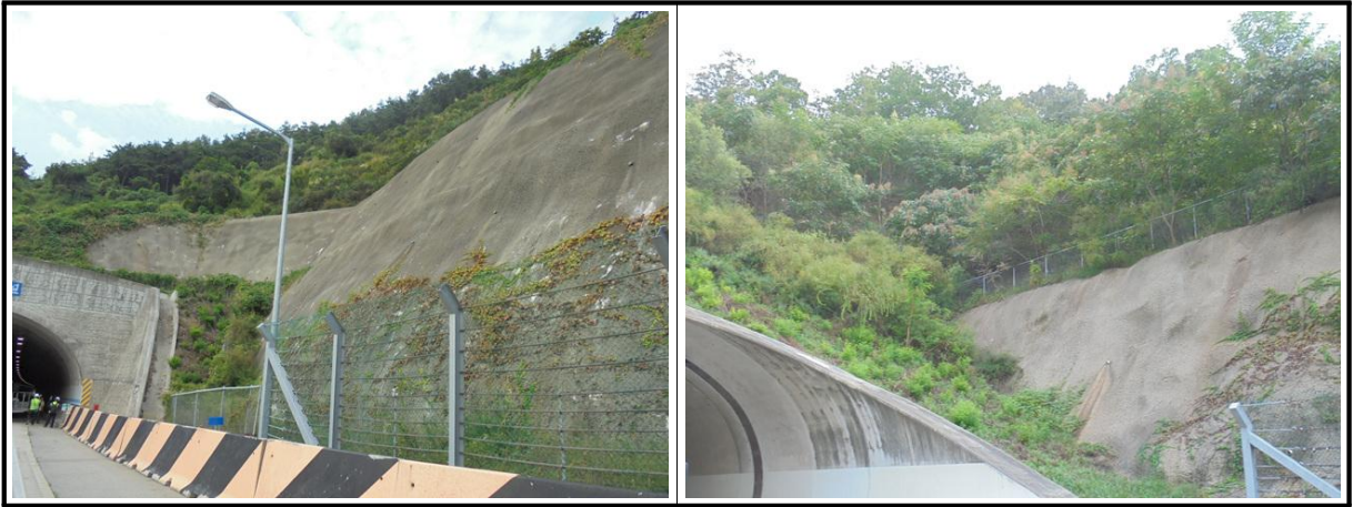
【사진 2.3.7】 사면 전경
