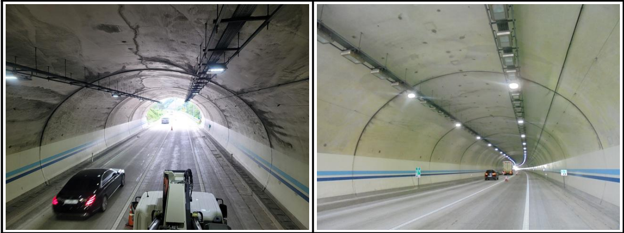
【사진 2.3.15】 라이닝 천단부 전경
