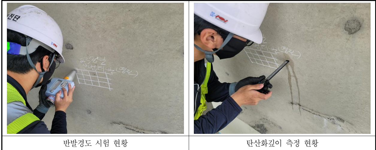
【사진 2.4.1】 콘크리트 내구성조사 현황
