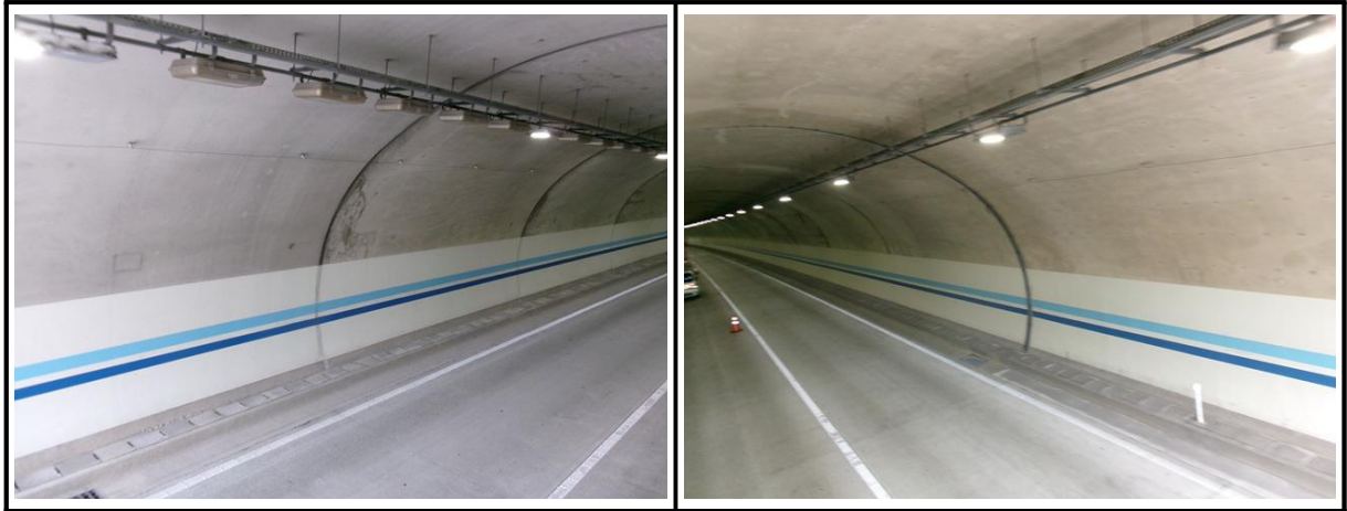
【사진 2.3.3】 라이닝 측벽부 전경
